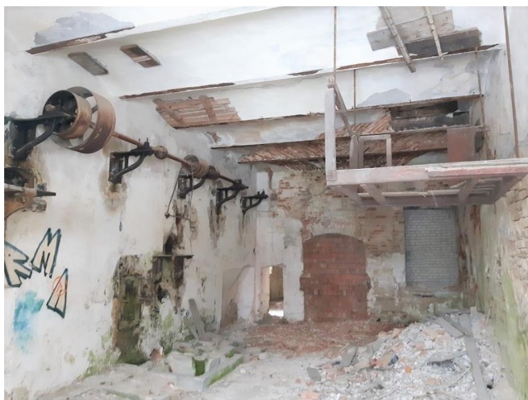
Vao mõisa viinavabriku masinaruumi interjäär transmissioonivõlliga. Autori foto.
