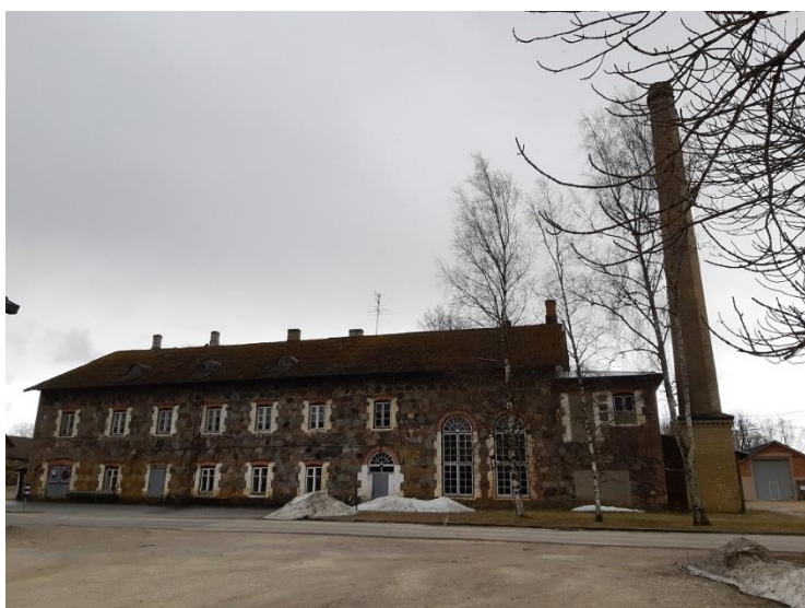
Jäned mõisa viinavabrik 2021.a aprillis. Autori foto.
