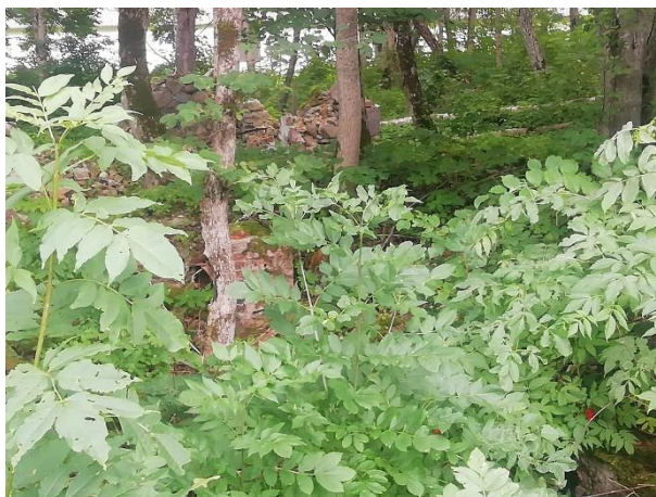
Tuhala mõisa viinavabriku varemed 2022.a augustis. Fotod: R.Alatalu
