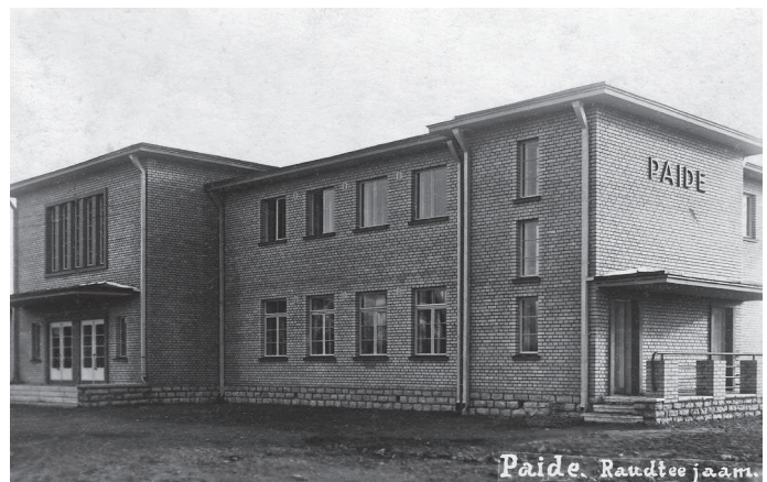
3.11: Modernistlik Paide raudteejaama hoone (1938, H. Otloot, G. Tumm) on üks elegantsemaid näiteid silikaattellise kasutusest raudteearhitektuuris. The Modernist Paide railway station (1938, H. Otloot, G. Tumm) is one of the more elegant examples of silicate brick railway architecture.
