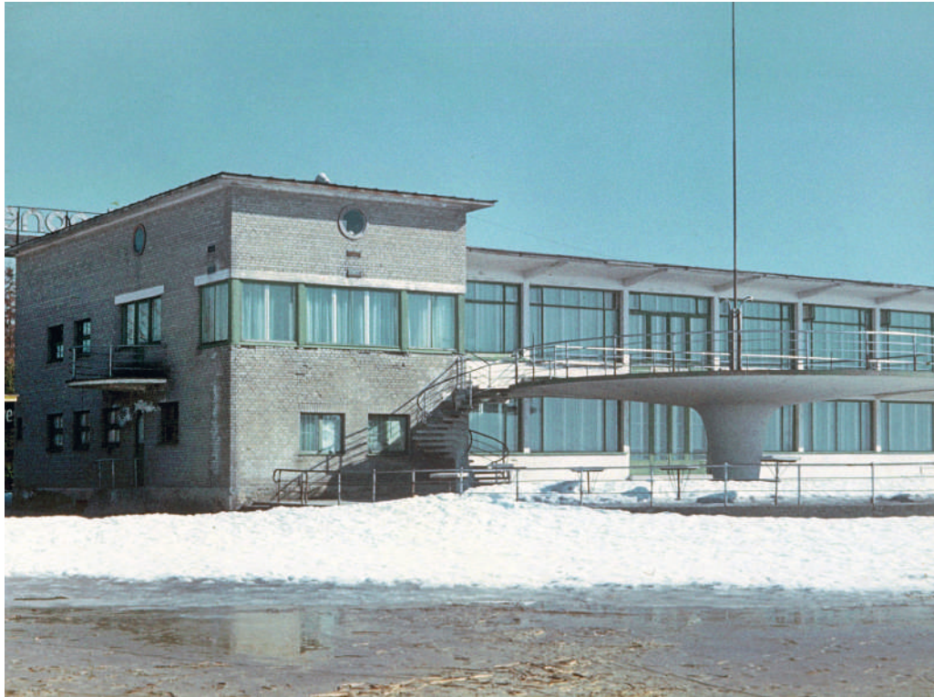
3.69: Pärnu rannakohvik 1981. Näha on kahjustunud silikaatkivipindu. Pärnu Beach Café 1981. The damaged surface of the silicate bricks is apparent.
