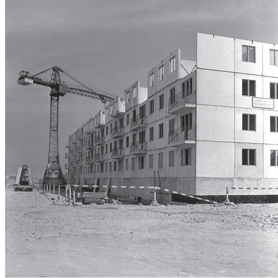
5.02: Esimeste suurpaneelilamute ehitus Tallinnas Pae tänaval 1961. aastal. Building the first prefab apartment buildings on Pae tänav, Tallinn, 1961.
