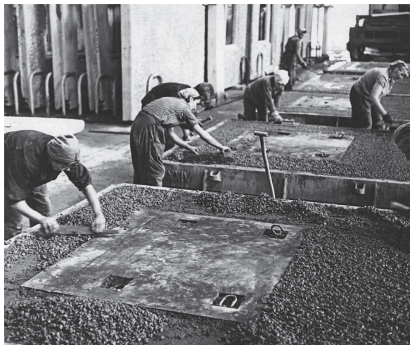
5.18: Killustikfaktuuri pealekandmine paneelile. Applying the grit onto the panel.
