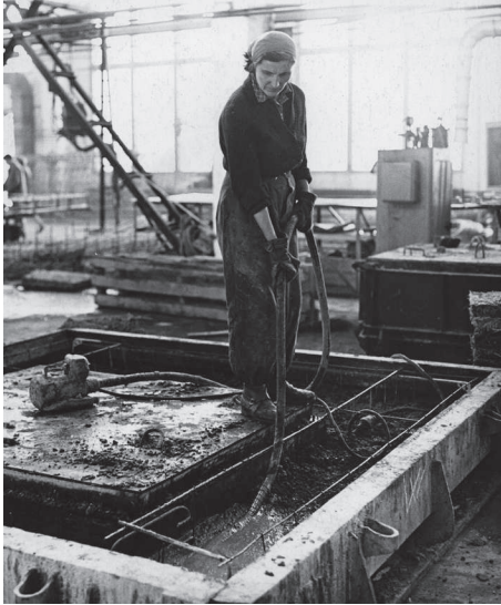
5.01: Paneeli valamine Tallinna Elamuehitus-kombinaadis. Pouring a panel at the Tallinn Housing Construction Plant.
