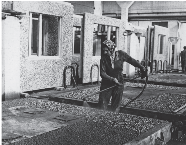
5.19: Tsemendijääkide pesemine killustikfaktuuri pinnalt. Washing off the excess cement from the grit surface.
