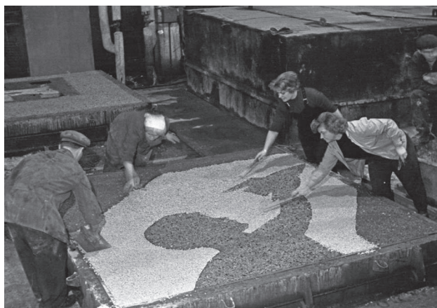
5.25: Tallinna Elamuehituskombinaadis valmib Akadeemia tee 14 otsaseina paneel. End wall panel for 14 Akadeemia tee in Tallinn under construction at the Tallinn Housing Construction Plant.
