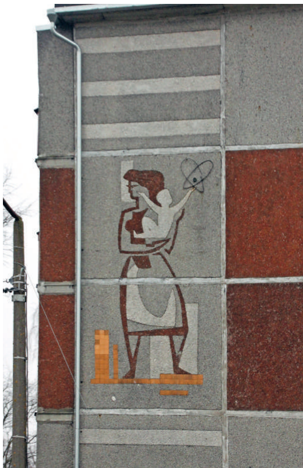
5.23: Tallinnas Ehitajate tee 51 asuva hoone otsaseina paneelide kujundamisel on kasutatud erinevaid materjale: kolme eri tooni killustikku, metalli, keraamilisi plaate. The end wall of 13 Angerja tänav in Tallinn has panels made with various materials - three different coloured grits, metal and ceramic tiles.
