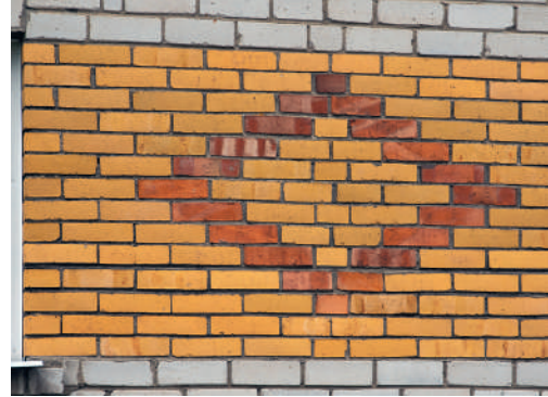
3.59: Kortermaja Vändras on ehitatud Järvakandis toodetud monteeritavatest puitkilpidest ja vooderdatud väljastpoolt tellistega. This apartment building in Vädra was built from prefab timber wall panels produced in Järvakandi and clad with brick.
