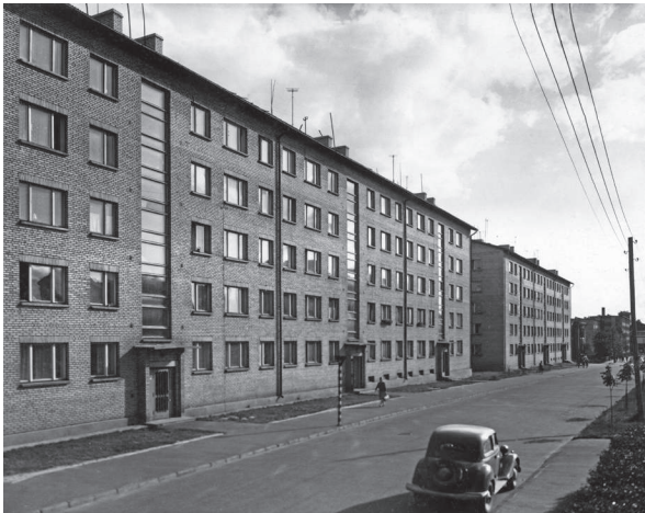
3.29: Seeria 1-317 korterelamud Tartus Tiigi tänaval. Series No.1-317 apartment buildings on Tiigi, Tartu.
