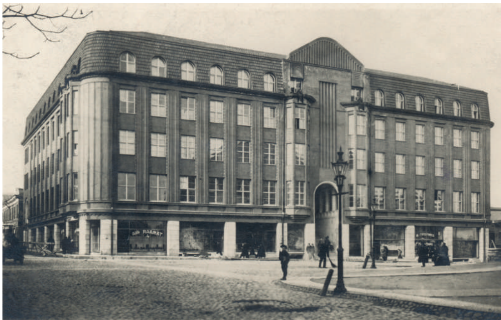
3.01: Vastastikuse Krediidühisuse hoone Tallinnas Pärnu mnt 10 (1911–1913, E. Saarinen) oli üks esimesi hooneid Eestis, mille ehitamisel kasutati silikaattellist. The Mutual Credit Society building at 10 Pärnu maantee, Tallinn (1911–1913, E. Saarinen) was one of the first buildings in Estonia to be built using silicate bricks.
