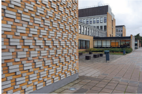
3.60: Tallinna Tehnikaülikooli (TTÜ) peahoone (1964, U. Tõlpus, H. Sepmann, O. Kontšajeva, A. Soans) puhul on muustrisse laotud tellisseinad osa hoolikalt kavandatud arhitektuursest tervikust. The patterned brick walls of the main building of Tallinn Technical University (1964, U. Tõlpus, H. Sepmann, O. Kontshayeva, A. Soans) are part of the carefully considered architectural concept.
