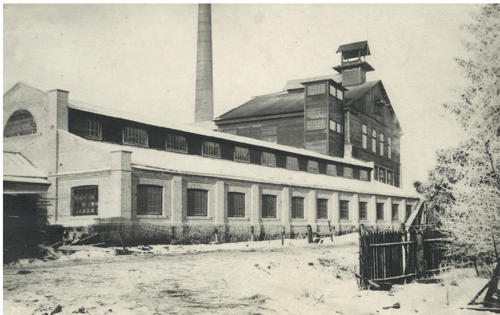
3.04: AS „Järvakandi tehased“ lõiketsehh [1920. aastate keskpaik] toob krohvimata silikaatkivipinnad tööstusarhitektuuri. The cutting facility at the Järvakandi Plant (mid 1920s) introduces unrendered silicate brick into industrial architecture.
