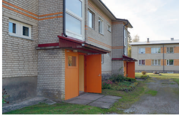
3.55: Punasest tellisest triipude sisseladumine oli käepärane kaunistusvõte, mis sobis hästi tüüpprojektide elavdamiseks. An easy decorative technique was to lay red bricks into the wall. This helped to enhance the appearance of standard designs.
