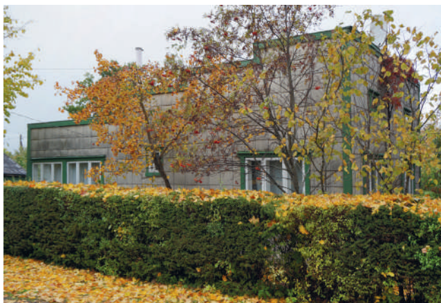
1.01: Elamu Toilas Pikk 25. Eterniitplaatide kasutamine seinaviimistlusmaterjalina oli Eestis erandlik. Residence at 25 Pikk tänav, Toila. The use of asbestos cement panels as a cladding material is rare in Estonia.
