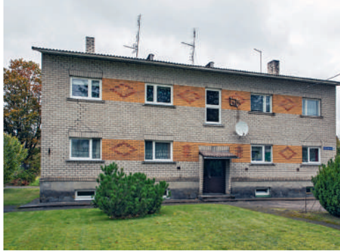
3.59: Kortermaja Vändras on ehitatud Järvakandis toodetud monteeritavatest puitkilpidest ja vooderdatud väljastpoolt tellistega. This apartment building in Vädra was built from prefab timber wall panels produced in Järvakandi and clad with brick.
