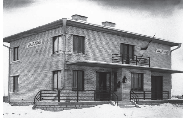
3.10: Vajangu silikaatkivist jaamahoone (1936, H. Otloot) on ehitatud lihtsa modernistliku tüüpprojekti järgi. Vajangu railway station (1936, H. Otloot), example of a simple Modernist standard design using silicate bricks.
