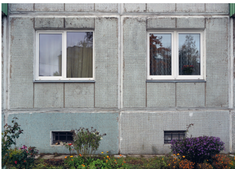
5.15: Keraamilistest plaatidest viimistlusega paneelmaja Tallinnas Seebi 36. Prefab apartment building with ceramic tile cladding at 36 Seebi tänav, Tallinn.
