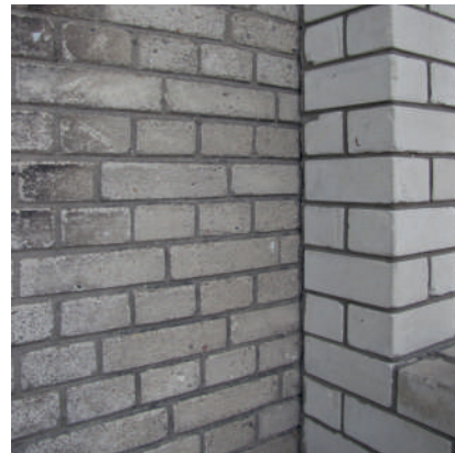
3.26: II maailmasõja eelsed (vasakul) ja nõukogude aja teisest poolest pärit väärikipinnaga silikaattellised (paremal). Pre WWII (left) and late Soviet era (right) smooth silicate bricks.
