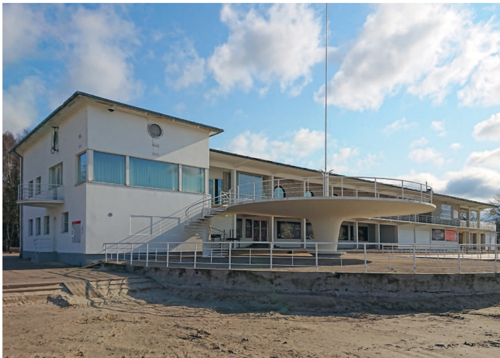
3.70: Pärnu rannakohvik restaureerituna, silikaatkiviseinad on üle krohvitud-värvitud. The restored Pärnu Beach Café. The silicate bricks have been rendered and painted.
