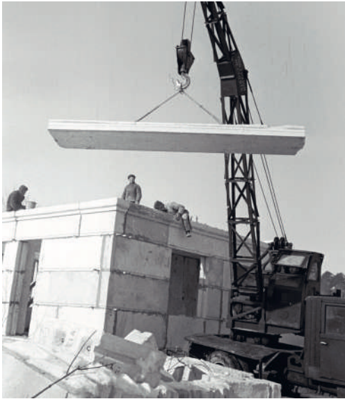
4.09: Silikaltsiidist ühepereelamu monteerimine Loksa keskkuses. Construction of a silicalcite home in Loksa.
