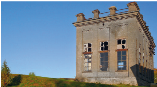
2.27: Sindi hüdroelektrijaama hoone [1931, J. Pärn, E. Tiltsen]. Sindi hydroelectric plant [1931, J. Pärn, E. Tiltsen].
