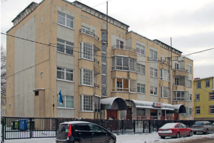
5.07: Eksperimentaalelamu Tallinnas Vana-Kalamaja 20a [E. Valdre]. Experimental apartment building at 20a Vana-Kalamaja tänav, Tallinn [E. Valdre].
