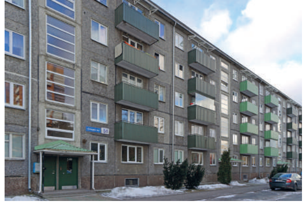
5.22: Tallinnas Ehitajate tee 51 asuva hoone kujundamisel on kasutatud kolmes eri toonis killustikfaktuuriga paneele. The building at 51 Ehitajate tee in Tallinn has panels with three different coloured grits.
