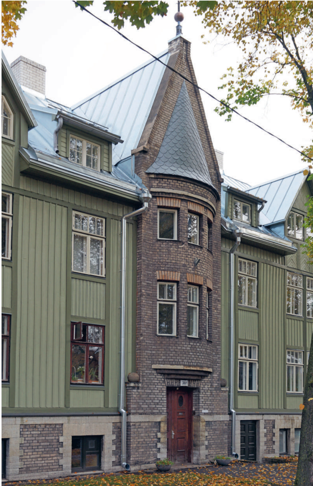
3.07: Elamu Tallinnas Kopli 38 (1928, V. Reinhardt) on näide ebaharilikust materjalikasutusest, kus silikaattellis on kombineeritud paekiviga. Residence at 38 Kopli tänav, Tallinn (1928, V. Reinhardt) is an unusual example of silicate brick and limestone used in combination.
