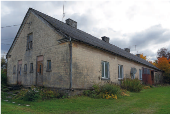
2.23: Esimene nopsa-süsteemis elamu Eestis valmis Kundas Jõe 7 [1929]. The first residential building built in Estonia using the Nopsa system. 7 Jõe tänav, Kunda [1929].
