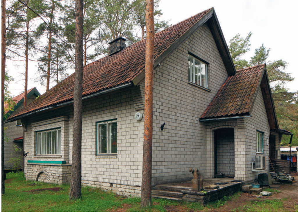
3.50: Eramu Tallinnas Nõmmel Edu 24 (E. Velbri) on hea näide rolokseinaga sõjajärgsest individuaalelamust. Home at 24 Edu tänav, Nõmme in Tallinn (E. Velbri) is a good example of a post-WWII home built using Rat-trap bond.
