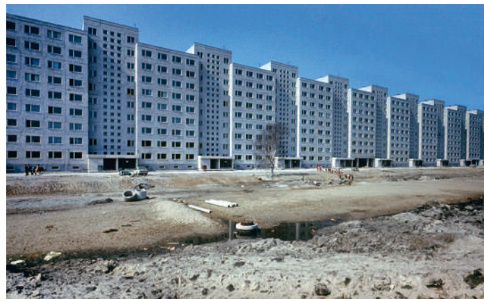
5.05: Tüüpprojekti 111-121 järgi valminud elamu Väike-Õismäel. Apartments in Väike-Õismäe built according to standard design No.111-121.
