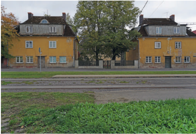
2.07: Lutheri vabriku tööliste elamud Tallinnas Vana-Lõuna tänaval [1922] ehitati moodsalt betoonkividest seintega. Housing for workers of the Luther factory on Vana-Lõuna tänav, Tallinn [1922] were built using modern concrete block walls.
