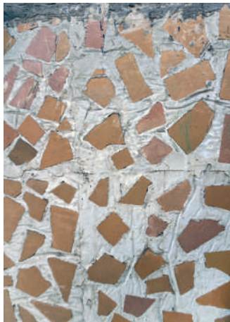
5.27: Soklipaneel Tallinnas Angerja 11 elamul. Basement level panel at 11 Angerja tänav, Tallinn.
