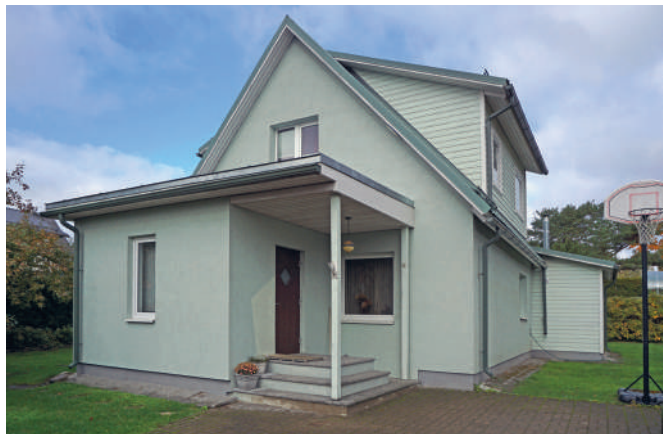
4.29: Renoveeritud silikaltsiidist ühepereelamu Tallinnas Rebase 6. A renovated silicalcite home, 6 Rebase, Tallinn.
